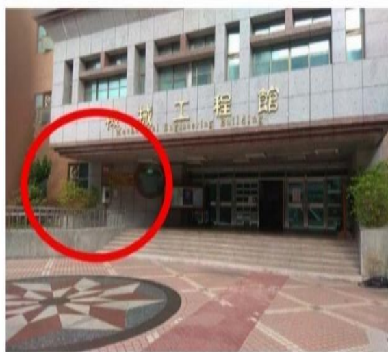
機械系大樓出口處 (107年10月增設)
