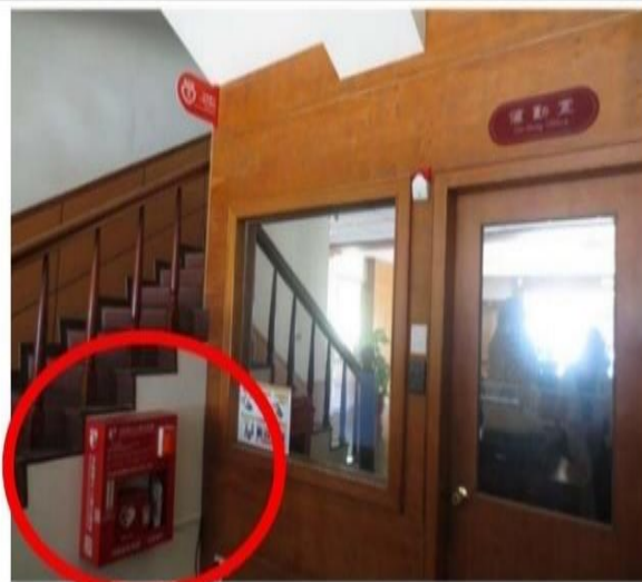
行政大樓一樓值班室外面
